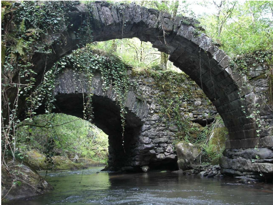
Las minas del paraje de Etxolaberry también fueron explotadas por los romanos. En primer término de la fotografía vemos un puente con el característico arco de medio punto de las construcciones latinas y las piedras unidas sin ningún tipo de masa. (Foto del autor).
