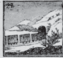
Pasa un túnel y se encierra un tren debajo de tierra.
